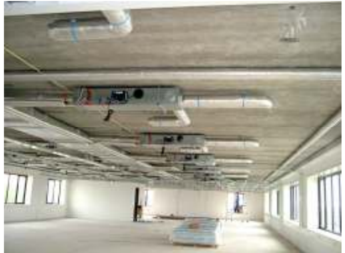
Typische lay-out van een Inductie-VAV systeem
