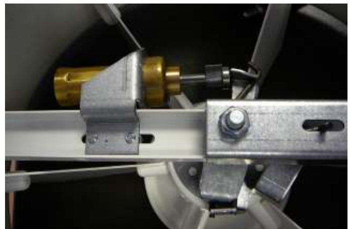
SDV met thermostatische motor in "warme" toestand
