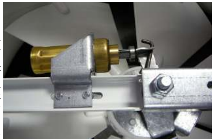
SDV met thermostatische motor in "koude" toestand
